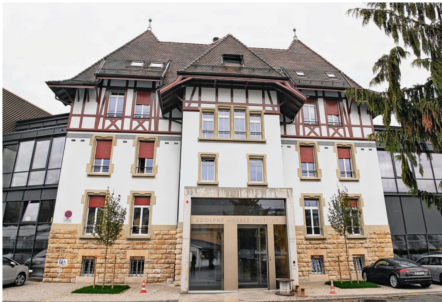
Das neue Gebäude des Adolphe-Merkle-Instituts verbindet gekonnt Altes mit Neuem.
